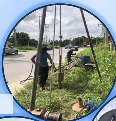
งานเจาะสำรวจชั้นดิน Boring Log
