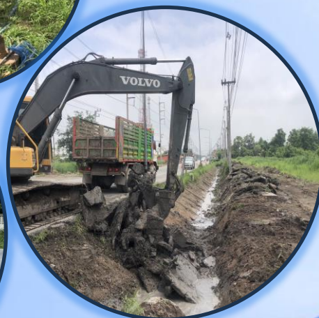
งานรื้อรางระบายน้ำข้างทาง
