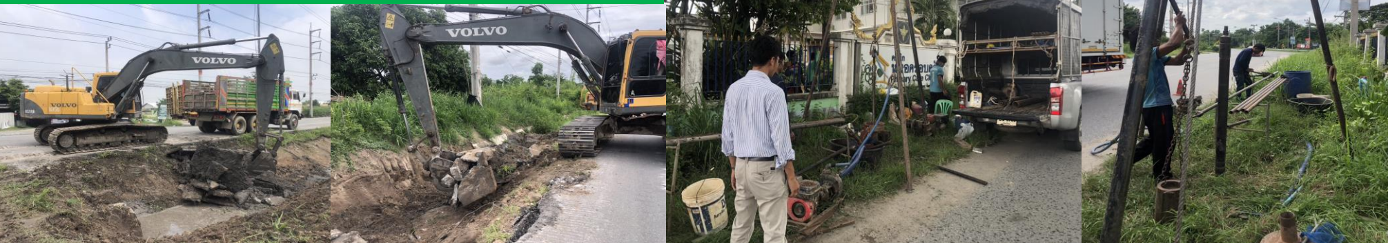
งานรื้อวางระบายน้ำด้านข้าง
