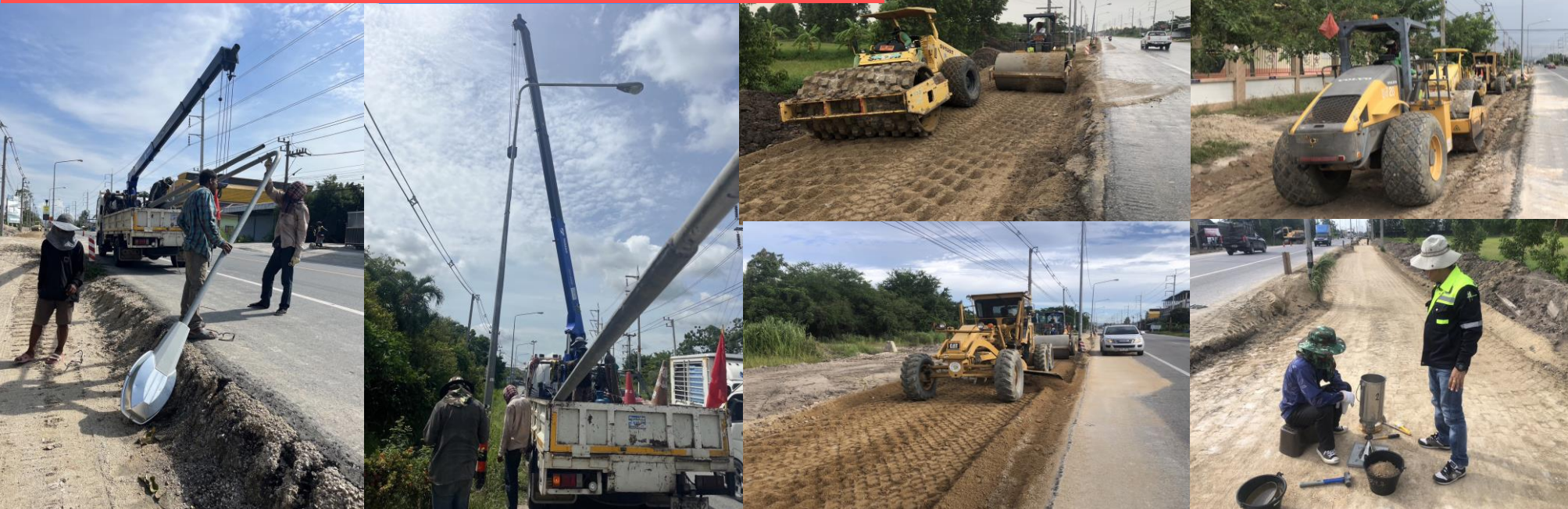
งานร้อยเสาไฟฟ้าแสงสว่าง
