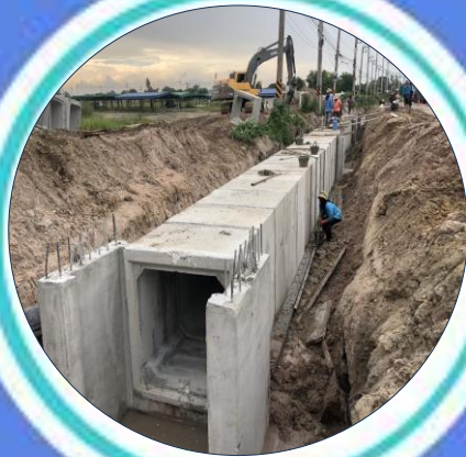
งานท่อเหลี่ยม คสล. พร้อมบ่อพัก คสล.
