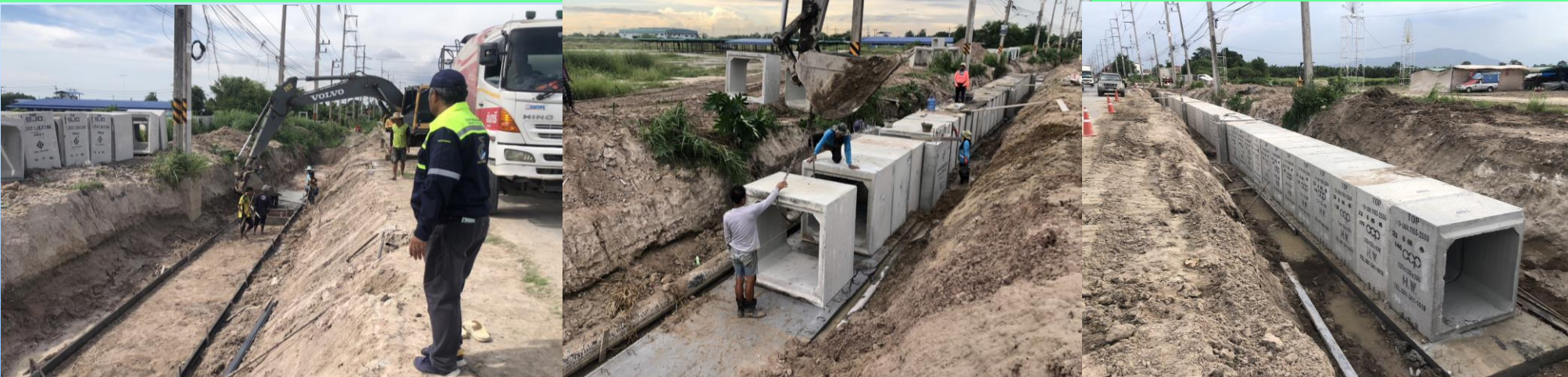
งานท่อเหลี่ยม คสล. ระบายน้ำด้านข้าง
