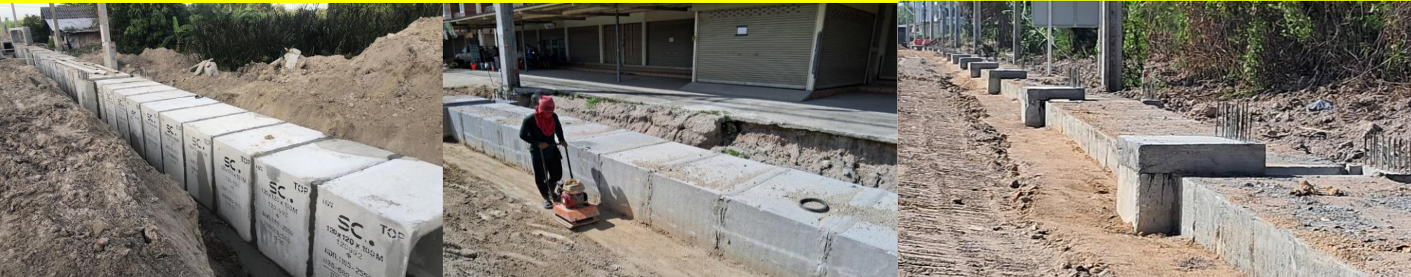
งานท่อเหลี่ยม คสล. ระบายน้ำด้านข้าง และงานบ่อพัก คสล.
