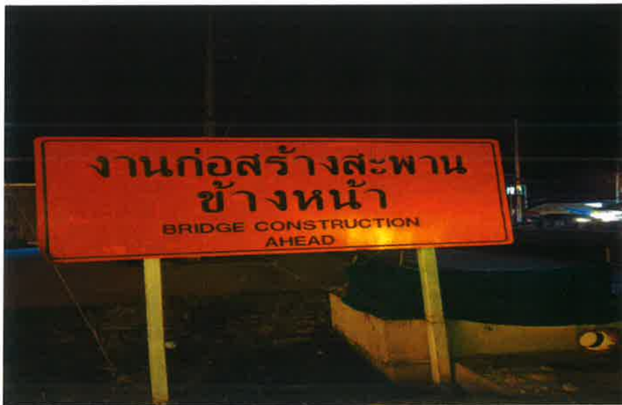
รูปที่ ๑ ถนนโครงการ กม.ที่ ๓+๒๓๑ ด้านขวาทาง
