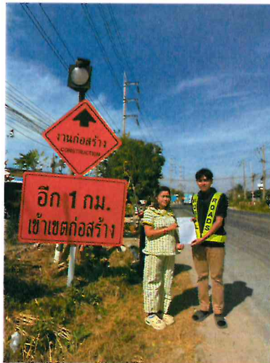
รูปที่ ๑ ถนนของโครงการ กม.ที่ ๙+๔๘๐ ด้านขวาทาง
