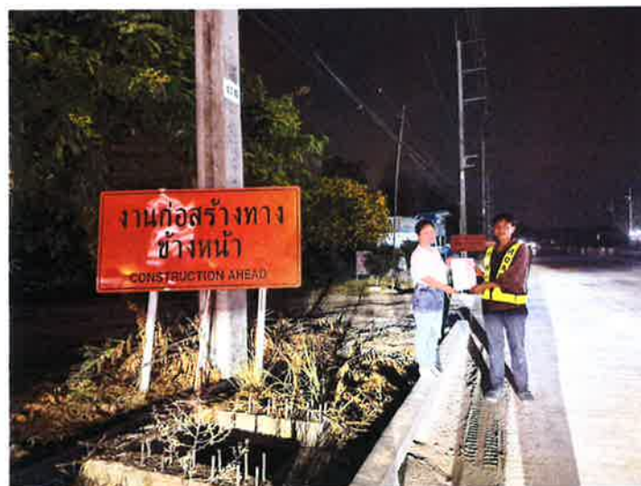
รูปที่ 2 ถนนโครงการ กม.ที่ 8+300 ด้านขวาทาง
