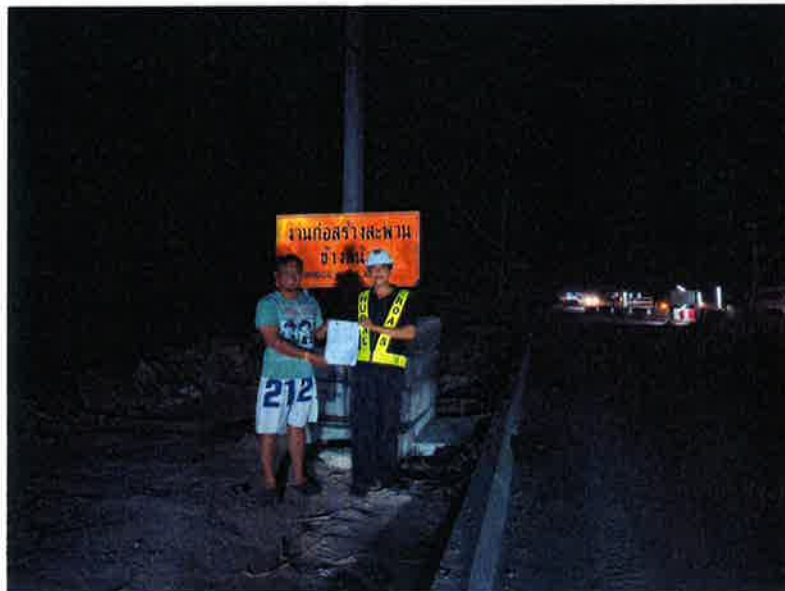
รูปที่ ๒ ถนนโครงการ กม.ที่ ๓+๖๒๐ ด้านขวาทาง
