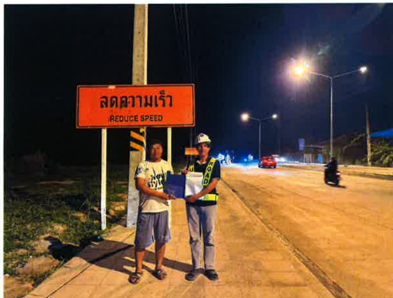
รูปที่ ๒ ถนนโครงการ กม.ที่ ๓+๓๐๐ ด้านซ้ายทาง
